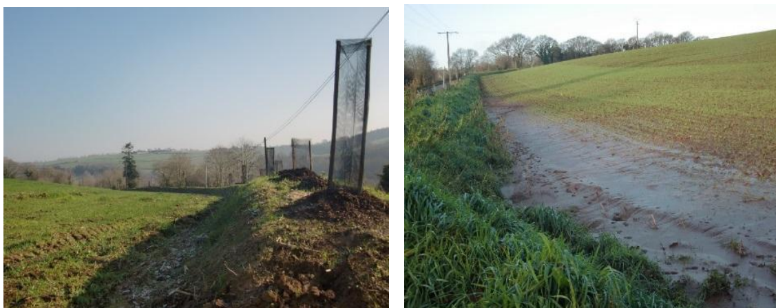
Réalisation de talus, bassin versant de l'Odet – Maitrise d'ouvrage : Sivalodet
