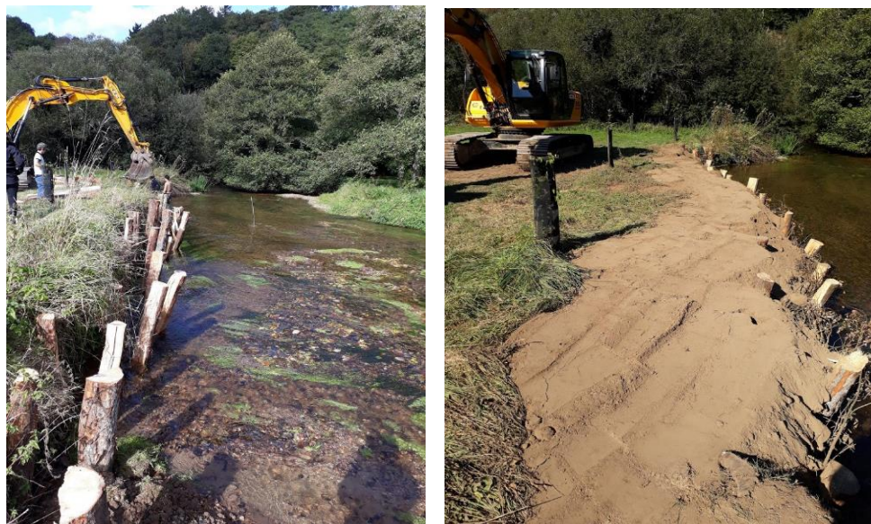
Restauration des berges du Jet avec des fascines – Maitrise d'ouvrage : Sivalodet
